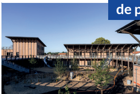
Groupe scolaire FRIDA KAHLO, Bruges CHARPENTE CENOMANE 2022
