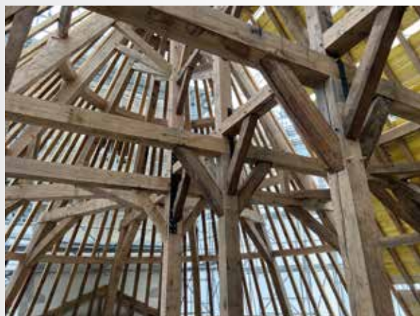
Entreprise Asselin : chantier Vannes
