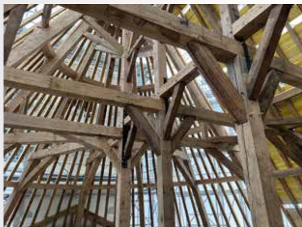
Entreprise Asselin : Chantier Vannes
